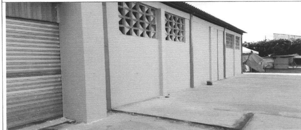
APLICAÇÃO MANUAL DE FUNDO SELADOR | EMASSAMENTO COM MASSA LÁTEX
