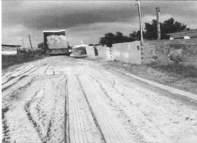
ATERRO COM AREIA FINA, COMPACTADO MECANICAMENTE, INCLUSIVE AQUISIÇÃO EM DEPÓSITO DE MATERIAL | TRANSPORTE COM CAMINHÃO BASCULANTE DE 14 M 3
