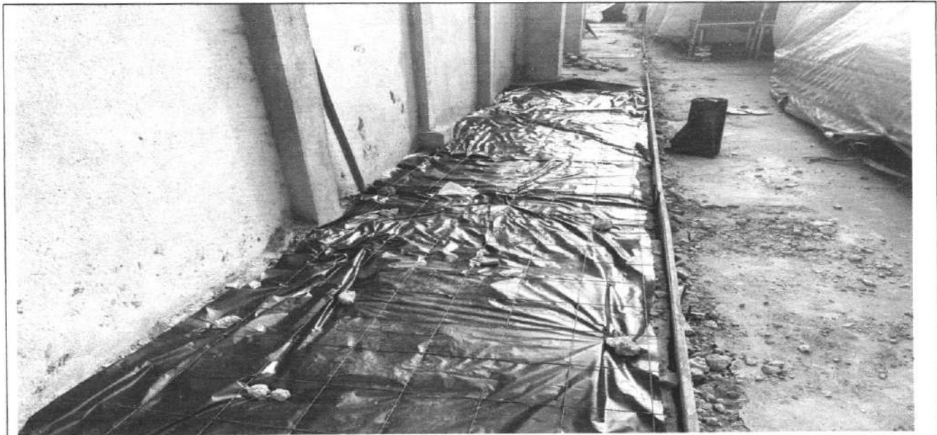
ATERRO DE ÁREAS | APLICAÇÃO DE LONA PLÁSTICA | FORNECIMENTO E INSTALAÇÃO DE TELA DE AÇO
