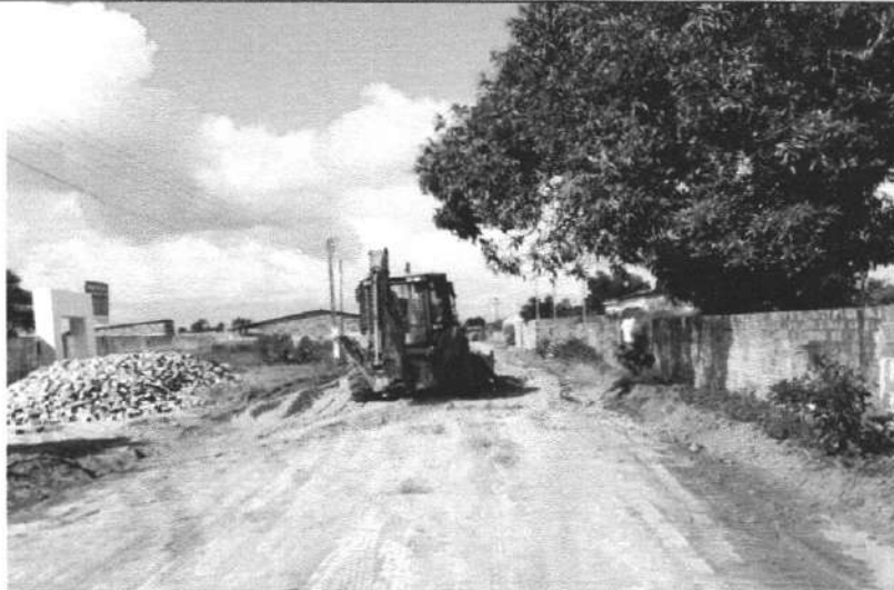
ATERRO COM AREIA FINA, COMPACTADO MECANICAMENTE, INCLUSIVE AQUISIÇÃO EM DEPÓSITO DE MATERIAL | TRANSPORTE COM CAMINHÃO BASCULANTE DE 14 M 3
