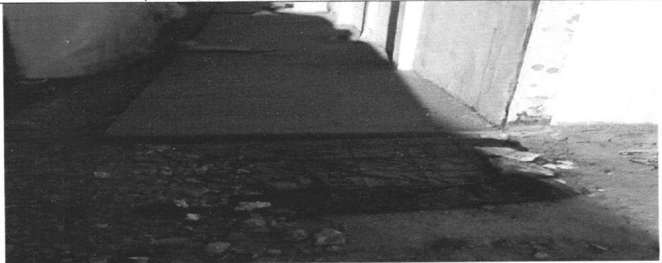
ATERRO DE ÁREAS | APLICAÇÃO DE LONA PLÁSTICA | FORNECIMENTO E INSTALAÇÃO DE TELA DE AÇO
