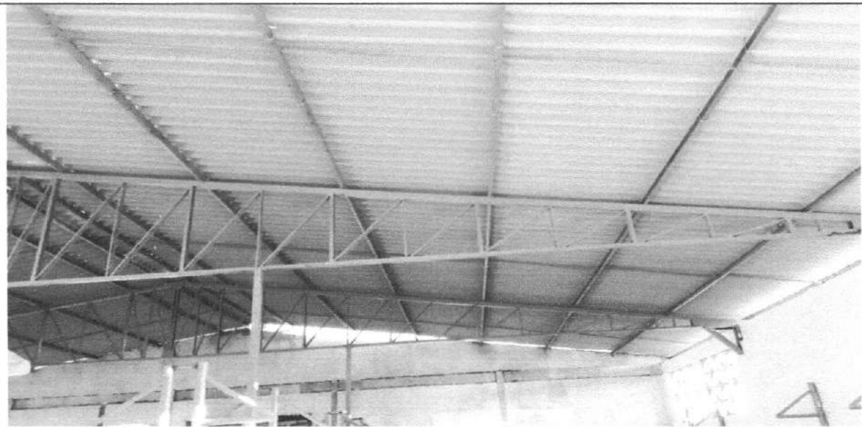
ESTRUTURA METÁLICA GALPÕES | APLICAÇÃO MANUAL DE TINTA LÁTEX
