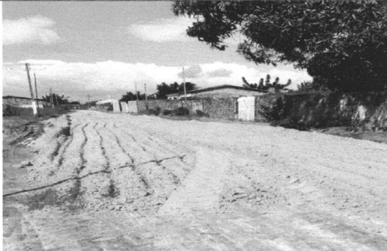
ATERRO COM AREIA FINA, COMPACTADO MECANICAMENTE, INCLUSIVE AQUISIÇÃO EM DEPÓSITO DE MATERIAL | TRANSPORTE COM CAMINHÃO BASCULANTE DE 14 M 3
